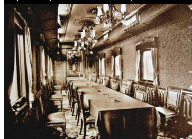
Вагон-столовая. Вагон с императорской столовой, в которой находились Александр III и Мария Федоровна с детьми и свитой, был полностью разрушен: без колес, со сплюснутыми и разрушенными стенами, он полулежал на левой стороне насыпи; крыша его лежала частью на нижней раме.
