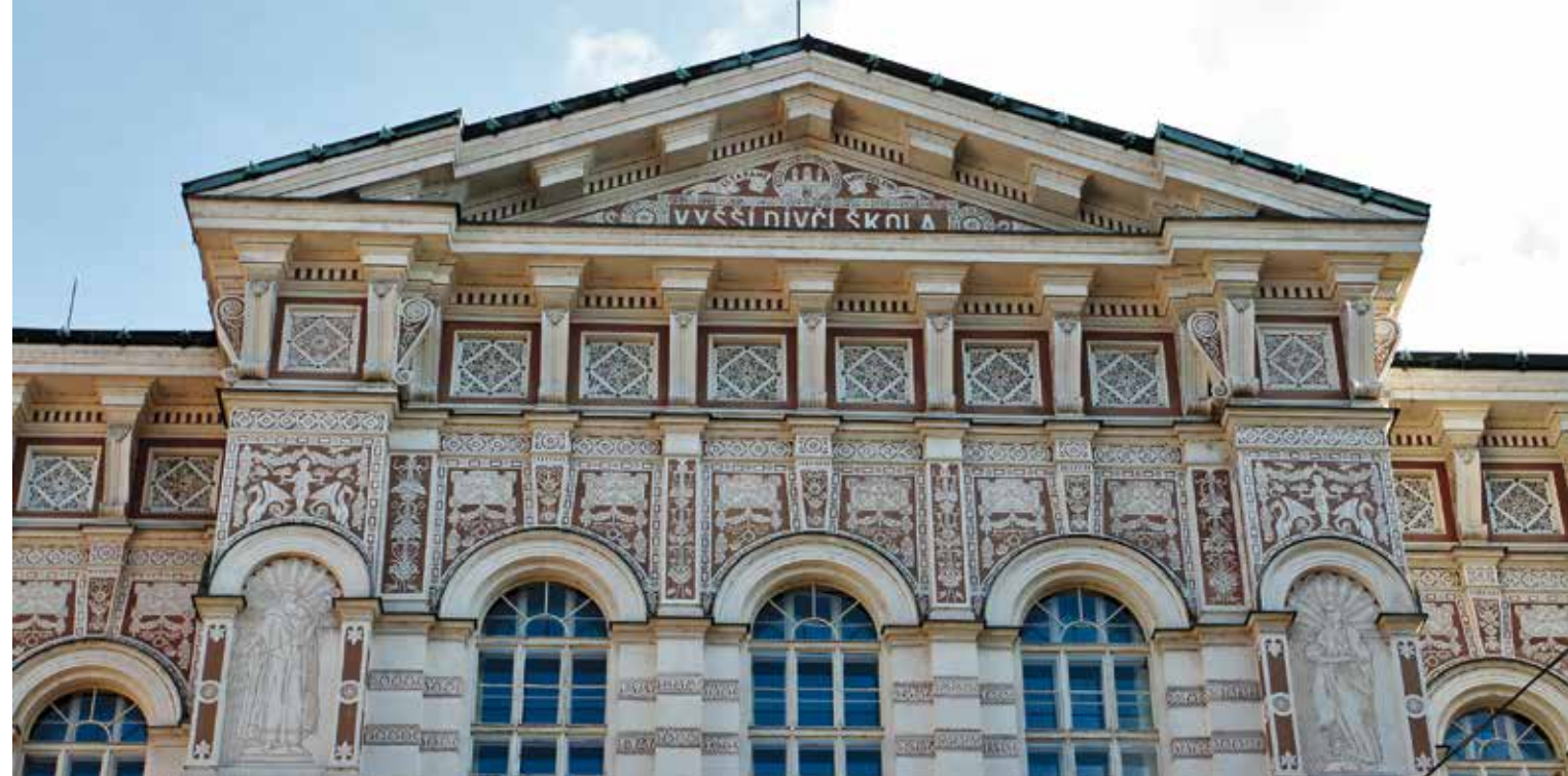
ЗДАНИЕ ВЫСШЕЙ ЖЕНСКОЙ ШКОЛЫ. АРХИТЕКТОР: ВОЙТЕХ ИГНАЦ УЛЬМАНН. VODIČKOVA 22 / ŠKOLSKÁ 19, PRAHA 1 — NOVÉ MĚSTO.
